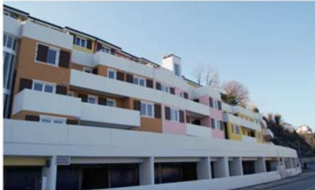
I lavori conclusi in via D'Annunzio e a Costa Alta.
